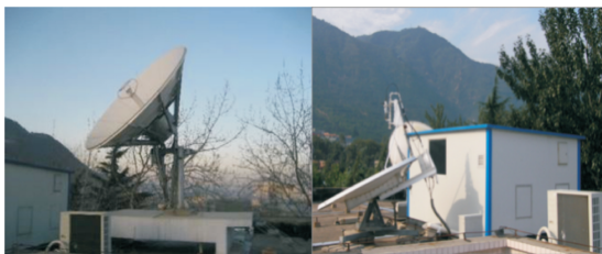
图 4 用于卫星双向时间传递的天线和机房
