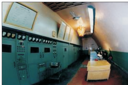
图2 长波授时台发射机控制机柜
