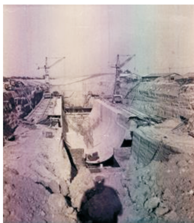
图1 长波授时台地下发播大厅建设现场
