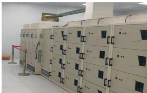
图 10 改造后的 BPL 固态发射机
